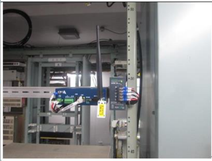
說明： LoRa 基站安裝完成 ↻
