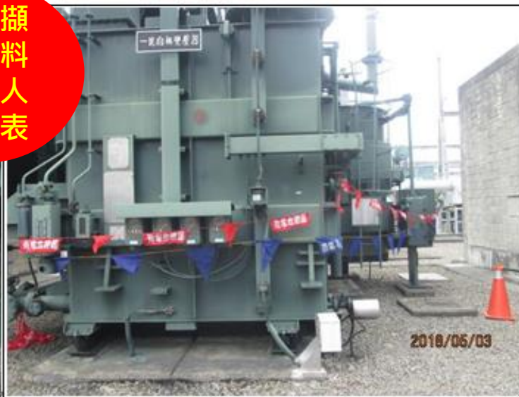
說明：#1 ATRR 相 TCG 安裝完成
