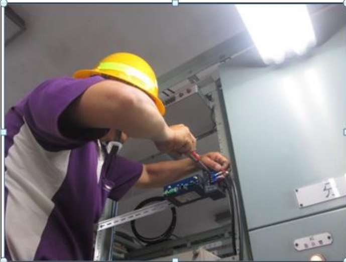
說明： LoRa 基站安裝 ↻
