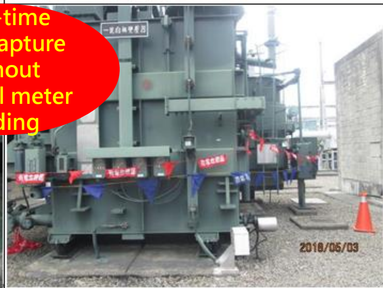
說明：#1 ATRR 相 TCG 安裝完成
