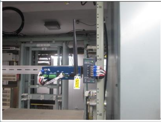
說明： LoRa 基站安裝完成 ↻
