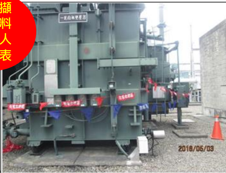
說明：#1 ATRR 相 TCG 安裝完成
